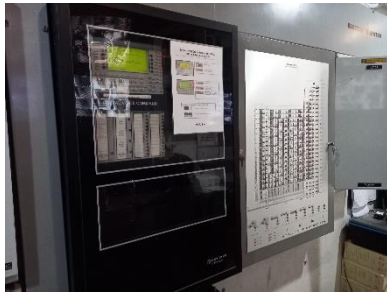
Fire Fighter Telephone System และ Graphic Annunciator Fire Alarm System
