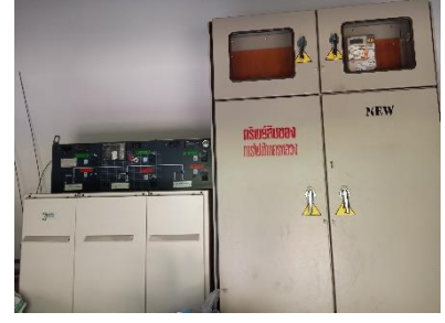
Ring Main Unit Room ของการไฟฟ้านครหลวง
